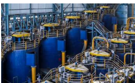
Construcción de plantas de tratamiento de agua
