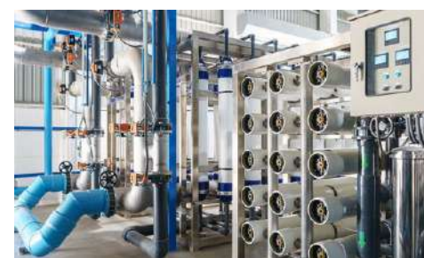
Construcción de plantas de tratamiento de agua
