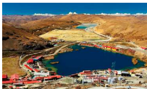
Gestión de proyectos para la construcción de campamentos mineros
