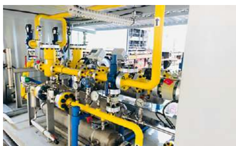
Gestión de proyectos para la construcción de sistemas de gas natural
